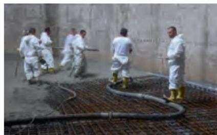
Innenansicht des 10.000 m<sup>3</sup> fassenden Trinkwasserbehälters mit dem Stahlskelett des neuen Stahlbetonbodens.
