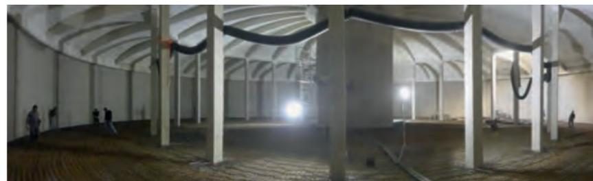
Die im Frühjahr 2017 begonnene Sanierung des ersten von vier Trinkwasserbehältern in Haßloch ist fast abgeschlossen. Nach der Erneuerung der Außenabdichtung startete im Spätherbst 2017 die Innensanierung. Alle Innenflächen des Behälters – Decke, Wände, Stützen und Boden – werden mit einer neuen, mineralischen Beschichtung versehen.
