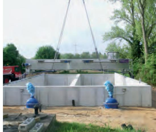
Mit dem Einsetzen des Schlammräumers ist die neue Absetzanlage im Wasserwerk Schierstein seit Frühling 2018 komplett.
