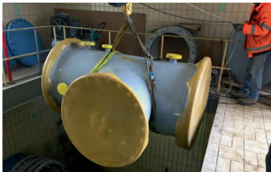
Eine der neuen Hauptkomponenten im Bauwerk 42 ist dieses T-Stück. Der Abzweig dient der Anbindung der Leitung nach Kelsterbach und Frankfurt-Süd.
