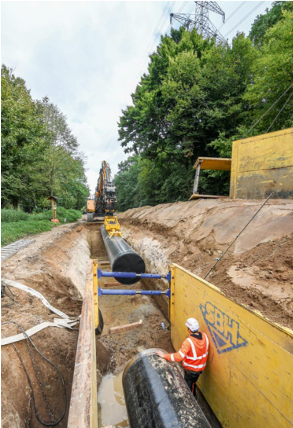
*Mit jedem Rohr wächst die neue Leitung um 12 Meter. Beim Einheben eines neuen Rohrs in den Graben bleiben die Schutzkappen bis zuletzt auf den Rohrenden.*
